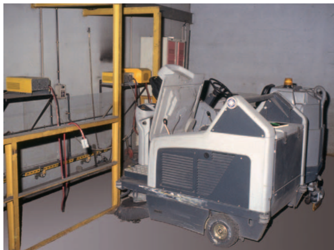
44. Local de recharge des batteries
